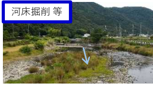
河床掘削等 鞍居川(上郡町)
