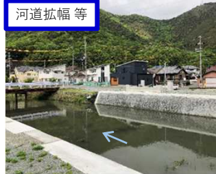
河道拡幅等 加里屋川(赤穂市)
