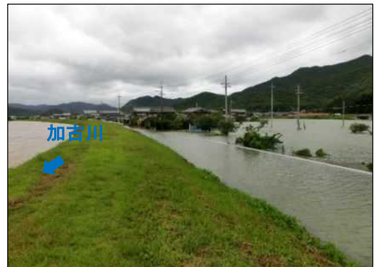
平成25年台風18号の浸水状況
