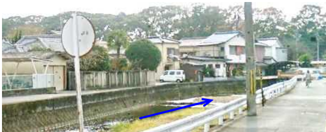
人家密集により川幅の拡大が困難な本川状況
