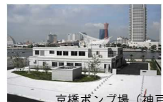
京橋ポンプ場(神戸市)
