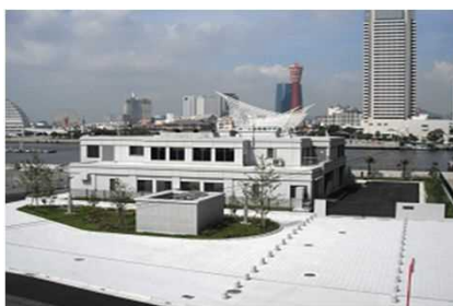
京橋ポンプ場(神戸市)
