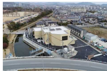
間の川ポンプ場(高砂市)
