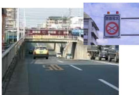
写真 道路アンダーパス部（通常時）と冠水情報板
