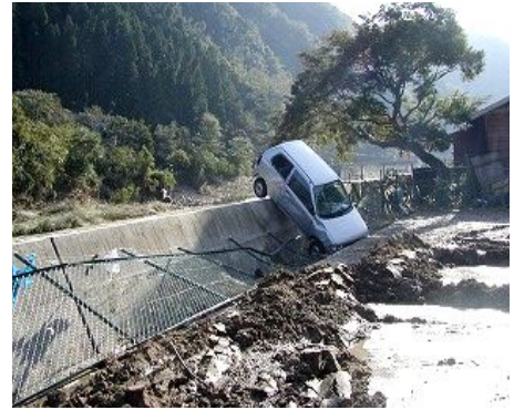
写真 2.2.3 平成 16 年台風 23 号の被災写真（武田尾地区）
