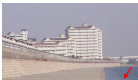
写真 2.2.5 高潮対策事業で整備した防潮堤
