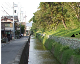
写真 4.1.1 ドレーン工法 の施工例
