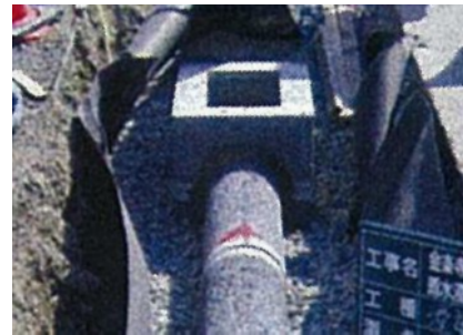
写真 2.2.11 浸透側溝
