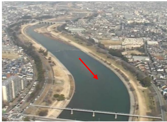
写真 2.2.1 下流部築堤区間
