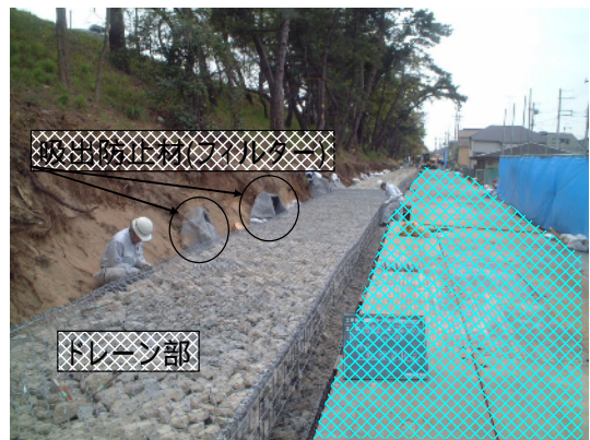
写真 2.2.4 堤防強化工事の例（ドレーン工）
