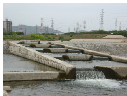
写真 2.2.20 床止めに設置された魚道
