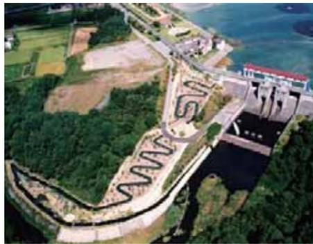
青野ダムでは、水道用水等のために貯めている水を、洪水前に一部放流して、洪水を貯める容量を増やしています。
