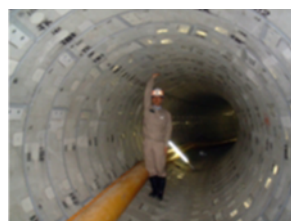
雨水貯留管 （左：西宮市 上：伊丹市）
