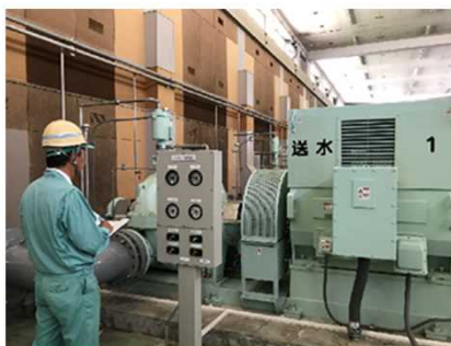
施設点検状況 (神戸市)
