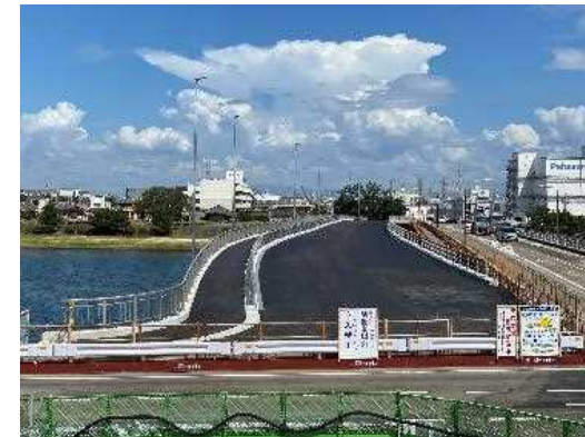
上部工施工中
