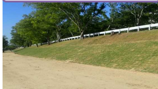
下流部築堤区間(堤防強化実施箇所)
