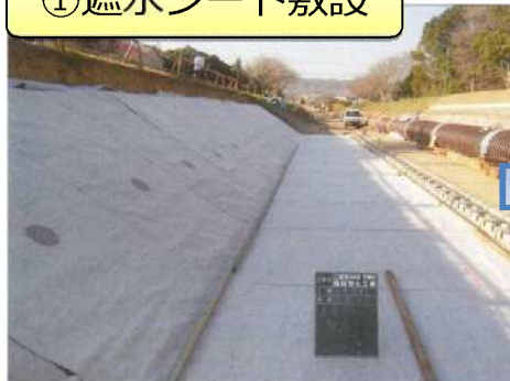
① 遮水シート敷設
