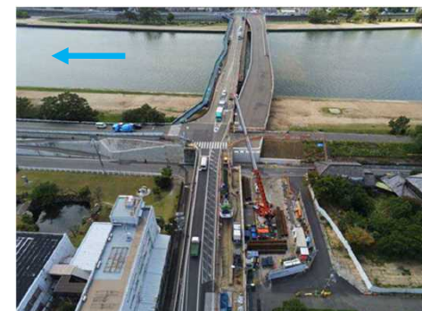
上部工施工中
