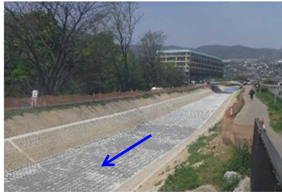
堤防強化工事
