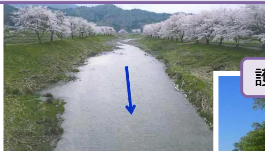
武庫川上流 (岩鼻橋上流)
