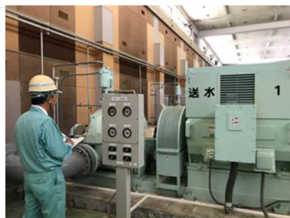
施設点検状況 (神戸市)
