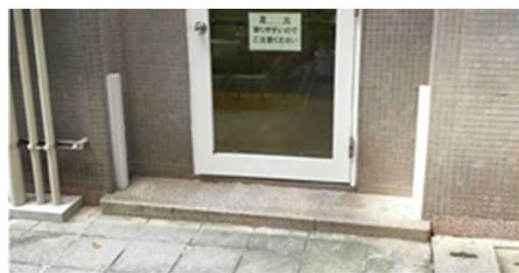
本庁舎中館 1F・止水板設置(尼崎市)
