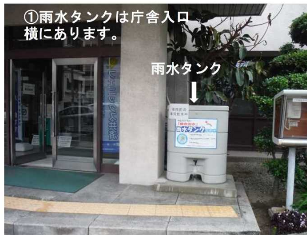
PR用雨水貯留タンクを県庁舎に設置し、普及啓発
