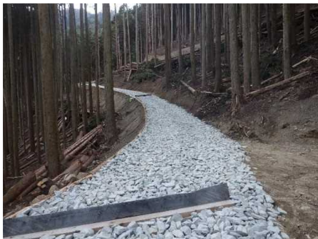
間伐・作業道の開設
