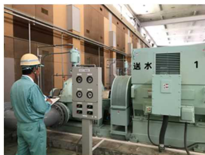
施設点検状況 (神戸市)
