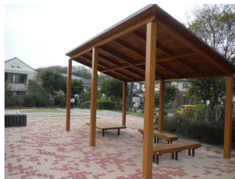
公園における舗装の浸透化（神戸市）
