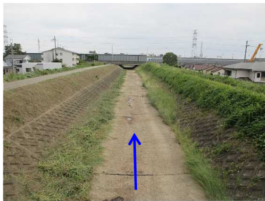
堤防強化工事
