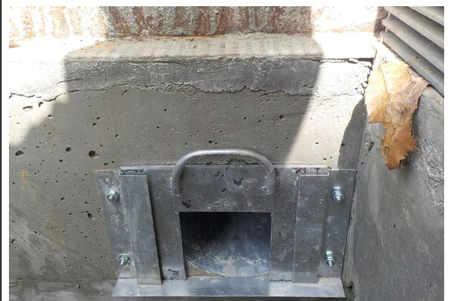
【オリフィス柵の状況写真】
