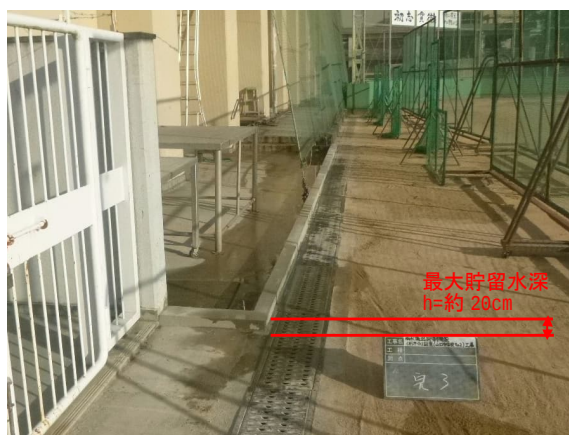
【整備後の写真】
