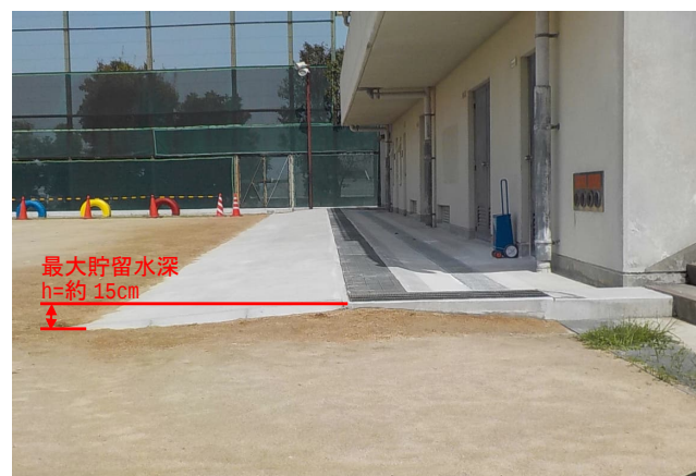
【整備後の写真】
