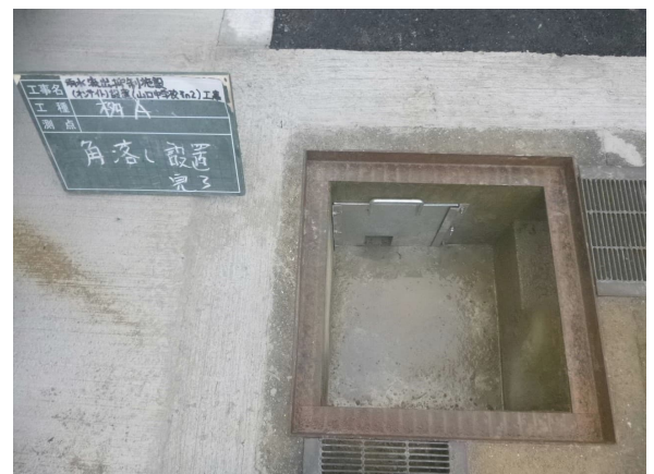
【オリフィス柵の状況写真】
