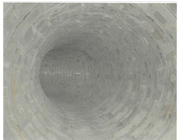
【シールド工 急曲線部施工完了写真】
