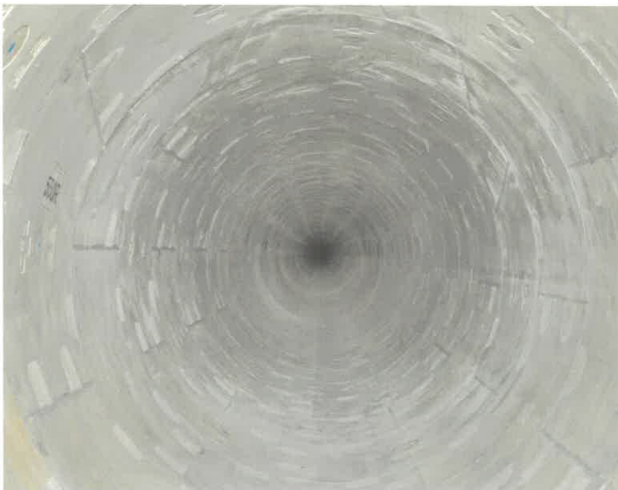
【シールド工 施工完了写真】
