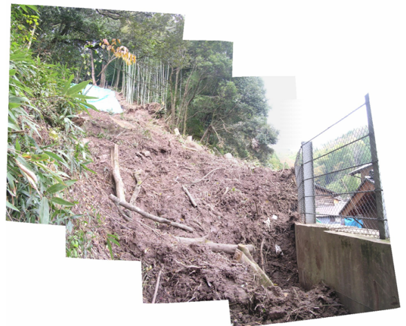
待ち受け擁壁が崩壊土砂を捕捉 (豊岡市)
