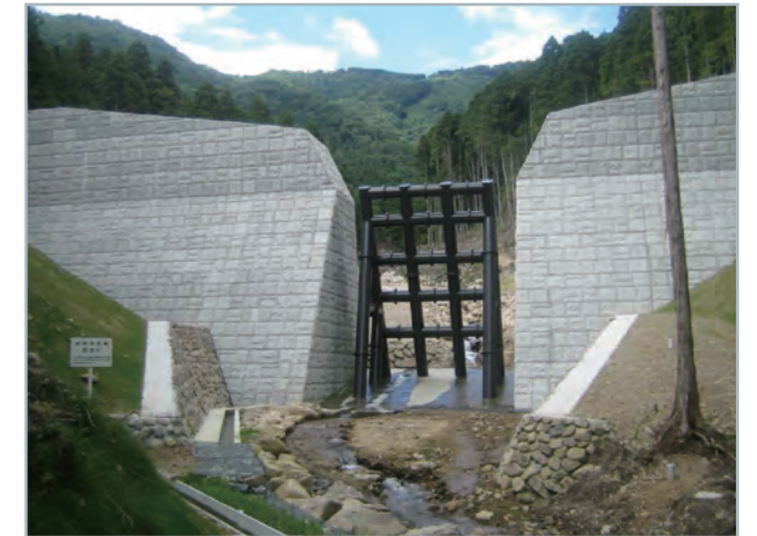
透過型えん堤 前田川えん堤 (神崎郡市川町上牛尾)
