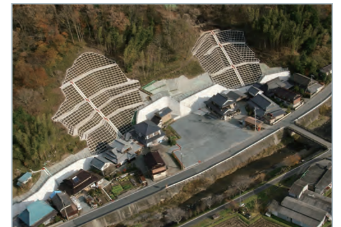
現場打ち法枠工 大向地区 (佐用郡佐用町福澤)
