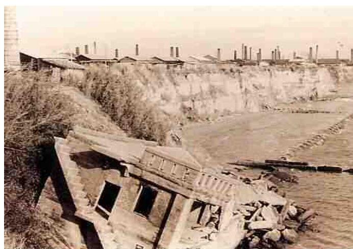
(海岸侵食により崩落したタコ壺工場～江井ヶ島地先～)
