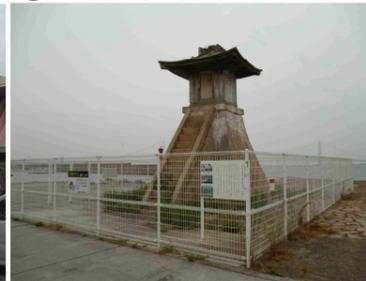
石積躯体と鉄筋コンクリート造の高さ 7.3m の灯籠。藩政時代から残る明石港のランドマーク
