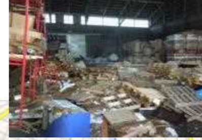
⑤ふ頭施設被害（上屋）
