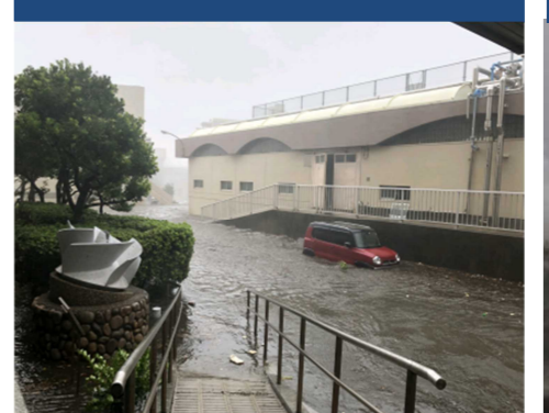
⑦浸水被害（枝川浄化センター）
