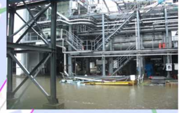
⑨ 浸水被害 (鳴尾浜)
