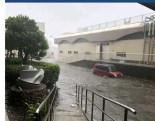
⑦ 浸水被害 (枝川浄化センター)
