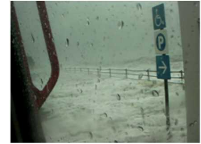
南護岸からの越波状況
