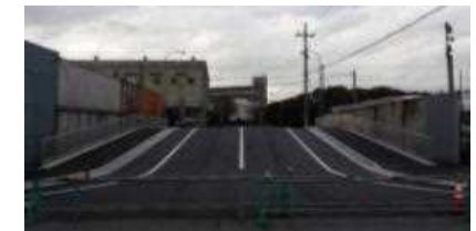
スロープ化実施済箇所
