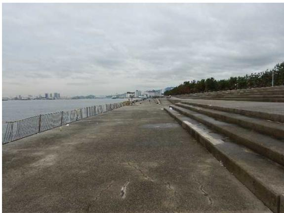
図-1 潮芦屋の海岸護岸と防護柵（応急復旧後）
