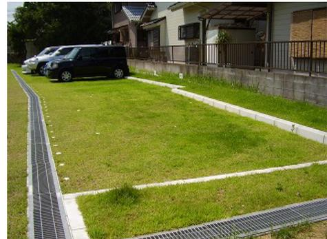
《整備後》プラスチックマットで補強した芝生化
