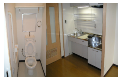
住宅のバリアフリー改修 （トイレの手すり・車いす対応キッチン）
