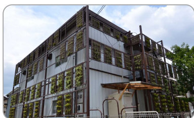
基盤造成型の壁面緑化の事例
