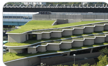
芝生による屋上緑化の事例
