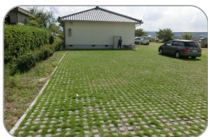
コンクリートブロックを用いた事例
