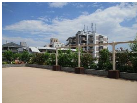
植栽による屋上緑化（尼崎市）
