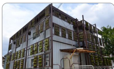
基盤造成型の壁面緑化の事例
