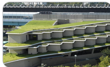
芝生による屋上緑化の事例
