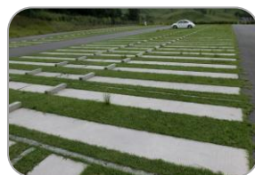
車輪部を補強している事例
