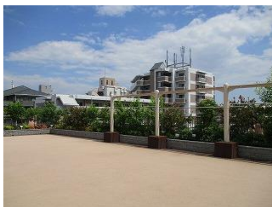
植栽による屋上緑化 （尼崎市）
