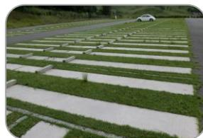
車輪部を補強している事例
