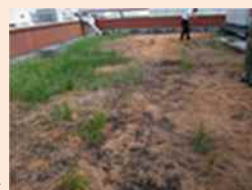
維持管理不足での枯損
