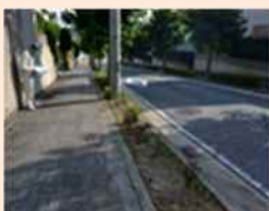
灌水不足による枯損
