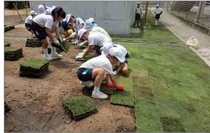
小学校の生徒たちによる芝張り
