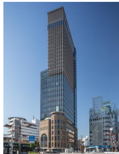
旧神戸阪急ビルの外観を再生
