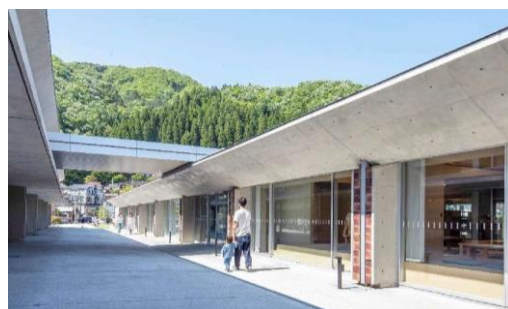
ホール棟と図書館棟の間に設けた小路
