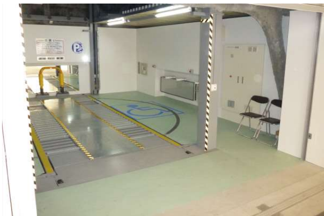
出入口～乗降スペース (経路上の段差なし、幅員確保)
