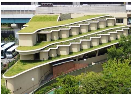
屋上緑化 （県民まちなみ緑化事業）
