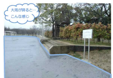
丹波年輪の里におけるグラウンドを調整池として活用した流域対策の実施
