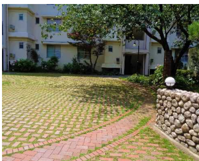
駐車場の芝生化 （県民まちなみ緑化事業）
