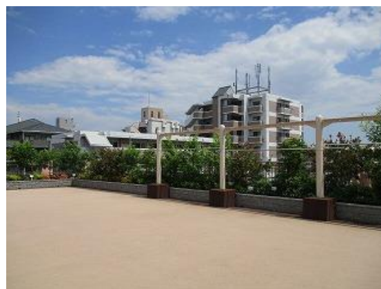
植栽による屋上緑化 (尼崎市)
