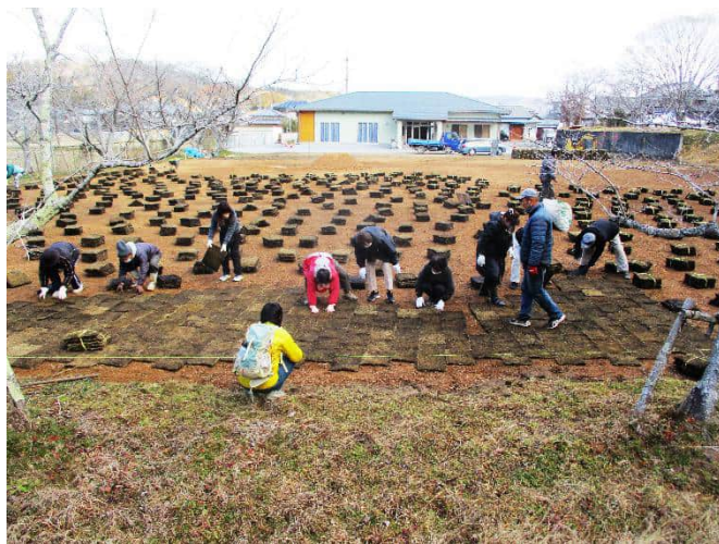
地域住民による芝張り（加西市）
