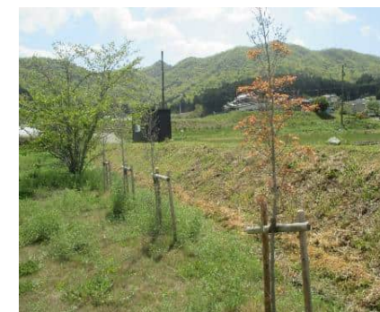
部分的に枯損した樹木
