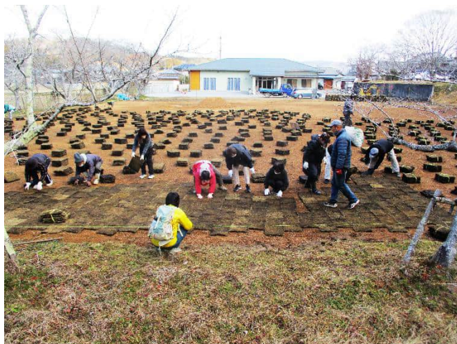
地域住民による芝張り（加西市）
