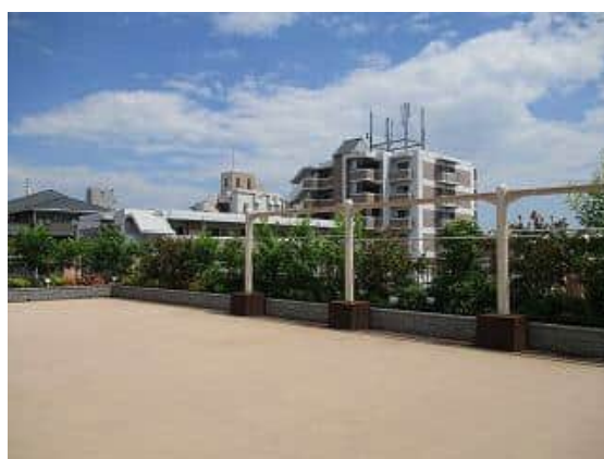
植栽による屋上緑化 （尼崎市）
