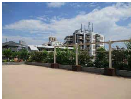
植栽による屋上緑化 (尼崎市)
