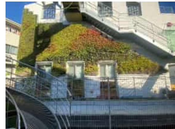
基盤造成型による壁面緑化 (明石市)
