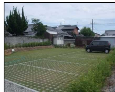
コンクリートブロックを用いた事例（加西市）
