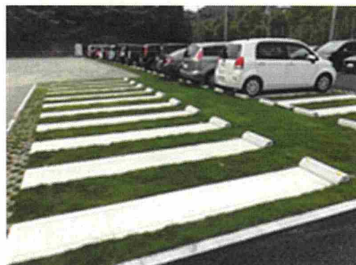
<整備後>コンクリートブロックで補強の芝生化駐車場(福崎町)
