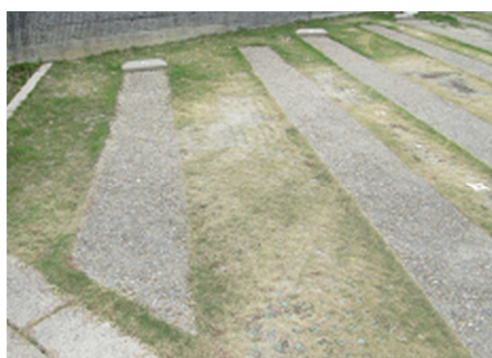
タイヤが乗る部分の土壌が固結
