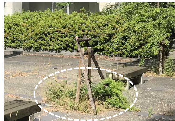
根鉢スペースの不足
