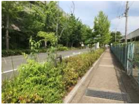
灌水不足による枯損
