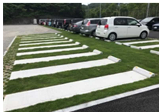
<整備後>コンクリートブロックで補強した芝生化駐車場（福崎町）
