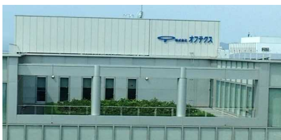
ポータルライナーから見た屋上緑化の状況
