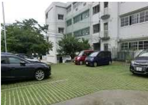
小学校内の駐車場の芝生化（西宮市）
