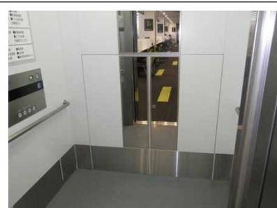
エレベーターは建物の東側と西側に2箇所設置されており、1基はストレッチャーが搬送できるトランク付きとなっている。また、1階のエレベーター前までは、出入口から誘導ブロックが敷設されており視覚障害者に配慮されている。
