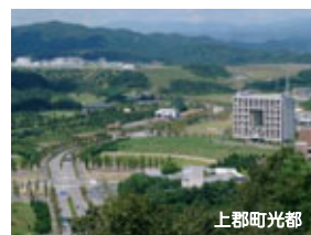
上郡町光都 自然とのバランスの とれた新しい町
