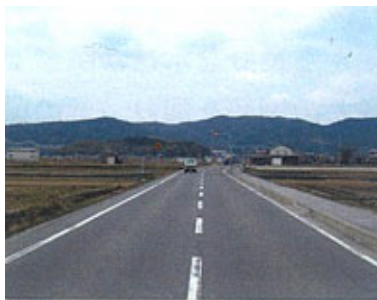
田園や山並みを道路景観に活かす場合は、必ずしも道路植栽を行う必要はない。 [桑原北山揖保川線(一般県道440号線)] 出典：西播磨道路景観マスタープラン
