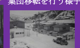
越冬住宅(共同牛舎も建設された)
