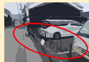
（板塀等へ改修）
