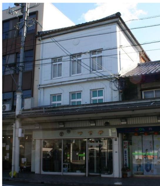
図 7-30 : 3 階増築部と瓦葺きの屋根
