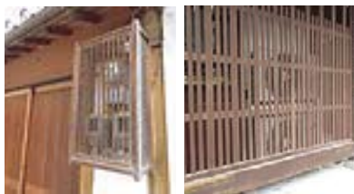
メーター・空調機の目隠しの事例
