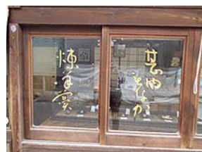
開口部ガラス 面設置広告物 の事例
