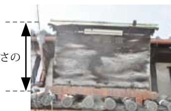
下屋庇上 木製看板 の事例
