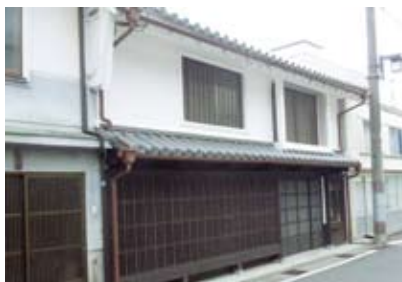
木製建具と格子の改修事例
