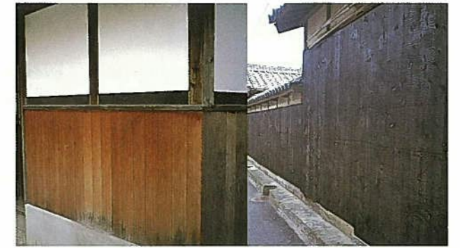
▲漆喰塗りと縦羽目板貼り
