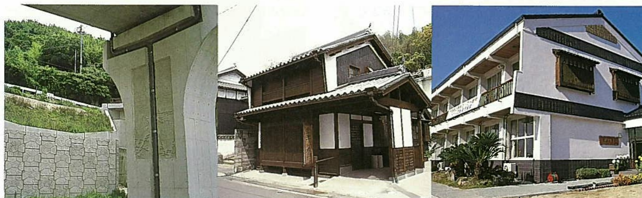
▲国道の橋梁、擁壁
