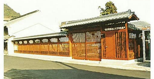
▲町なみに配慮して修景した公共施設の駐車場
