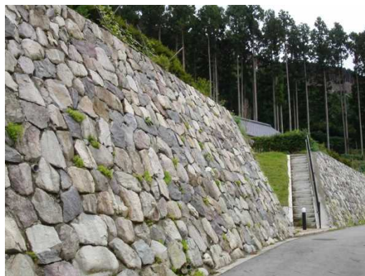
自然石による擁壁の事例
