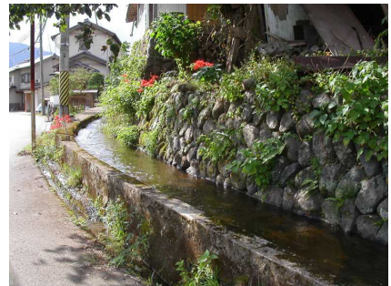
集落内を流れる水路も、重要な景観資源。 (養父市八鹿町八木)
