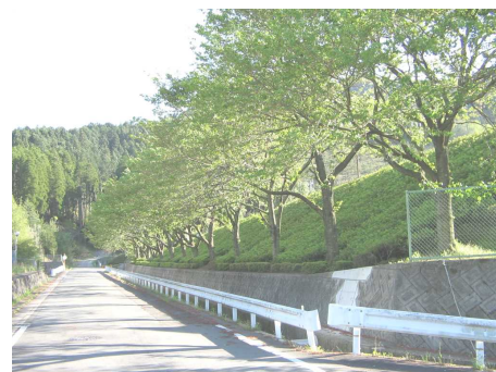
樹木を用いた法面緑化
